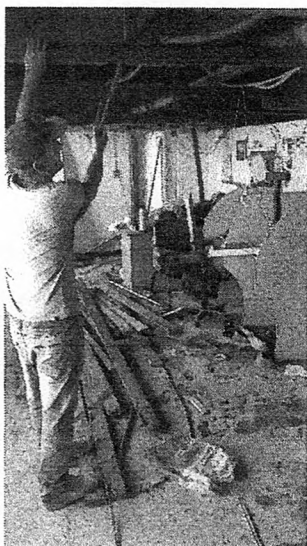
Retirada e elevação da Estrutura do forro de PVC
