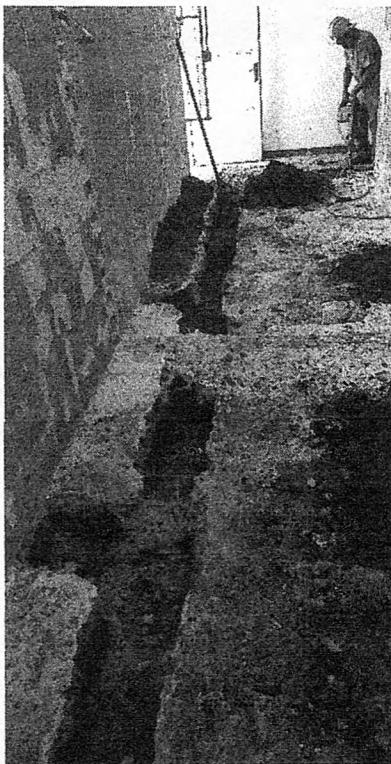
Escavação manual de valas
