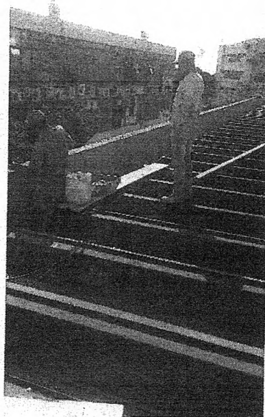
Execução do novo revestimento da platibanda
